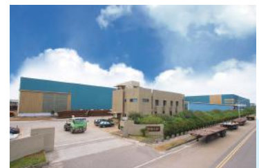
彰濱廠 面積：15,000坪 風電水下基礎基樁直管工藝設計研發 中心、大口徑鋼直管產製中心、鋼捲 裁剪、圓棒物流中心
